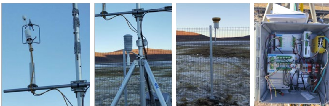
Configuración de redes y software del sistema, montaje del analizador de gases y anemómetro ultrasónico, sonda de temperatura y humedad del aire y pluviómetro
