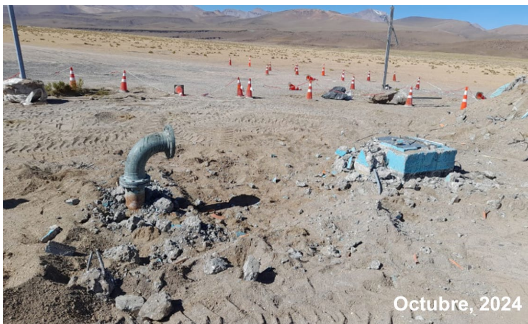
Figura 5.2: Fotografía del proceso de desmantelamiento del pozo P-1 en octubre del 2024. Fuente: Elaboración propia.
